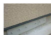
ひび割れの基礎補強
