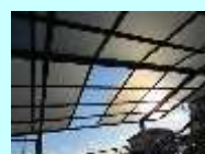
カーポート屋根修理
