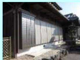
サッシ取替後
