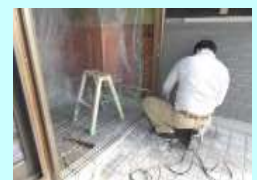
玄関建具枠解体
